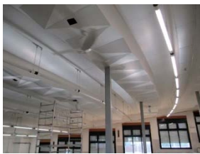
TR6 Instal·lació de ventiladors a l'auditori.
