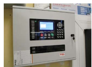
TR5 Nova central incendis per la planta 2 i 3. PIU
