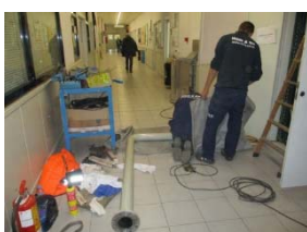
TR4 Reparació canonada contra incendis
