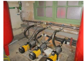
TR3 Renovació de canonades generals xarxa d'aigua.
