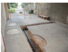
TR5 Substitució canonada general xarxa d'aigua.
