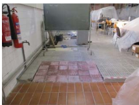
TR3 Reforma lab. química. Millora de desaigües i rampes d'accés.
