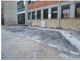
TR5 Paviment nou a l'aparcament de minusvàlids. PIU
